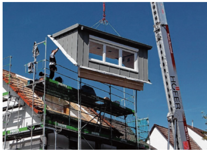
Millimetergenau werden Komponenten wie diese Gaube vorgefertigt und dann in kürzester Zeit eingebaut. Foto: Höfer
