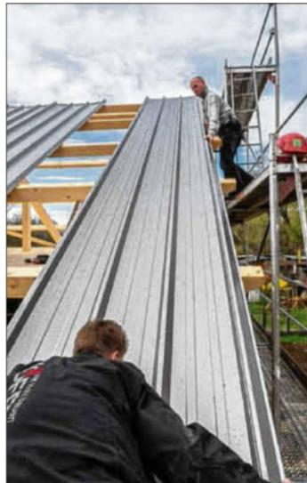
Das Dach des Aufwindhofs wird mit Blech eingedeckt.
